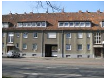
Zwei Gebäude mit gemeinsamer Durchfahrt
