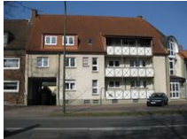
Zwei Gebäude mit einseitiger Durchfahrt
